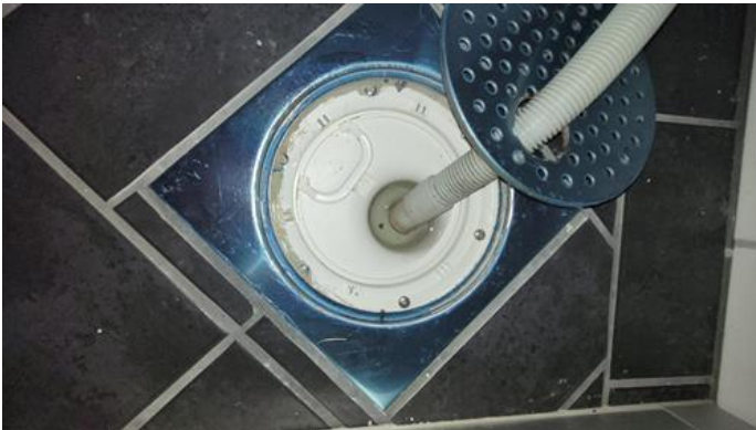
Våtrom - [Sluk bad.]
