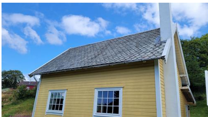
Utvendig - [Oversiktsbilde tak.]
