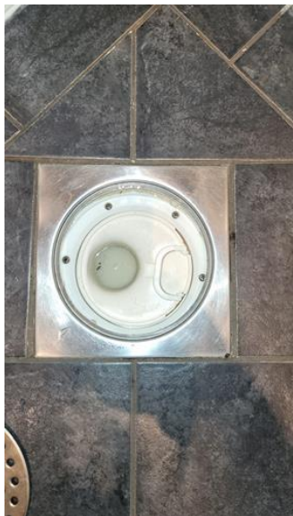
Våtrom - [Sluk bad.]
