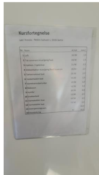
Elektrisk anlegg - [Kursfortegnelse leilighet.]
