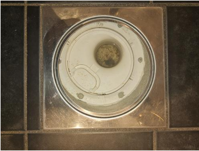
Membran, tettesjikt og overgang til sluk. - [Sluk]
