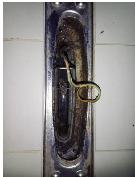
Membran, tettesjikt og overgang til sluk. - [Sluk i dusjsone. Bad 2.etasje.]
