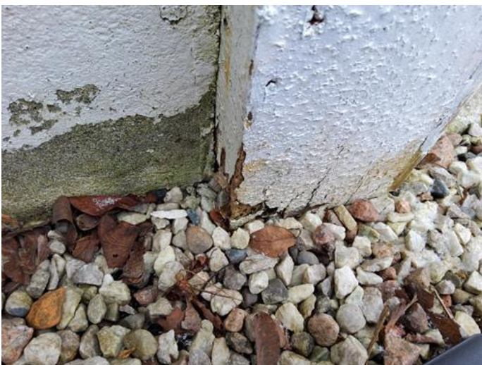
Beskrivelse - [Råteskader]
