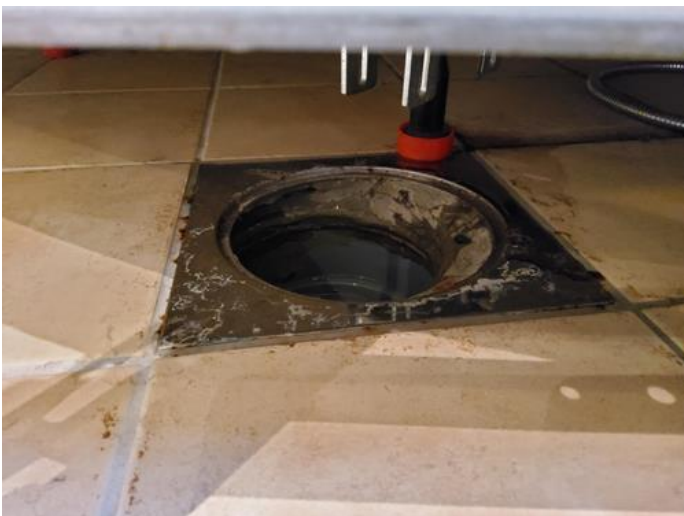
Membran, tettesjikt og overgang til sluk. - [Sluk under badekar bad mot øst]
