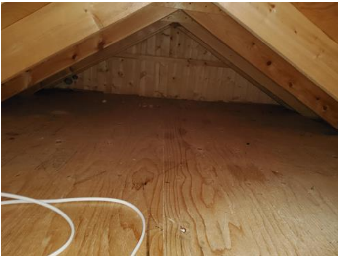
Loft - uinnredet / råloft - [Kaldtloft over tilbygg mot vest]
