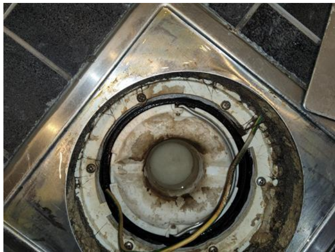
Membran, tettesjikt og overgang til sluk. - [Sluk dusj bad 1.etasje ]
