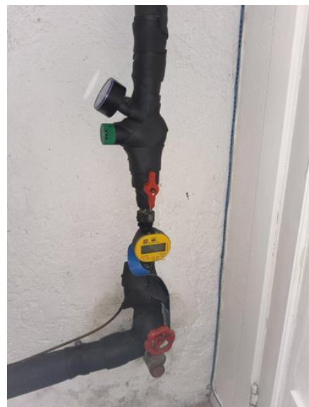
Tekniske anlegg, VVS anlegg (Sjekkpunkter utover det som er inkludert i andre rom) - [Hovedstoppekran ]
