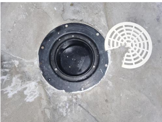
Tekniske anlegg, VVS anlegg (Sjekkpunkter utover det som er inkludert i andre rom) - [Sluk tekniske rom ]
