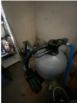
Nytt renseanlegg/pumpe for basseng
