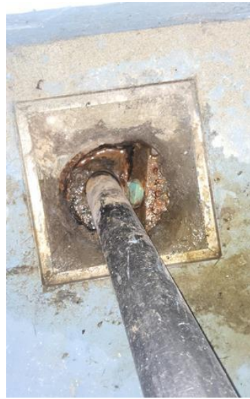
Avløpsrør (ink. sluk) - [Sluk på vaskerom ]
