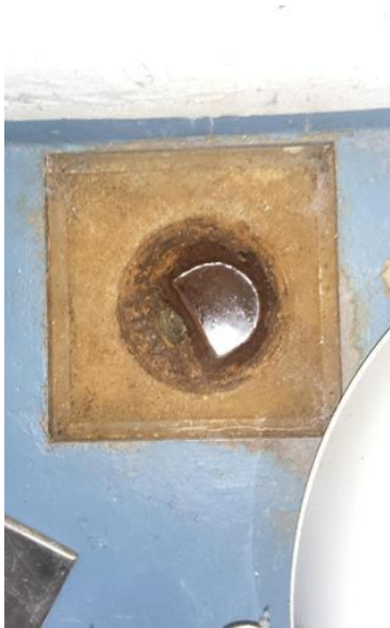
Avløpsrør (ink. sluk) - [Sluk på vaskerom ]
