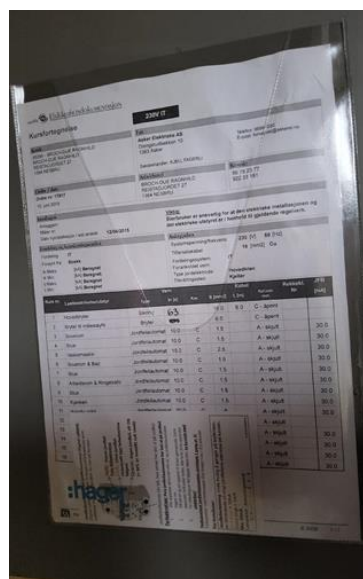
Elektrisk anlegg - [Kursfortegnelse ]
