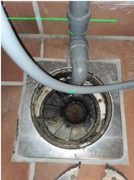
Membran, tettesjikt og overgang til sluk. - [Sluk vaskerom underetasje ]
