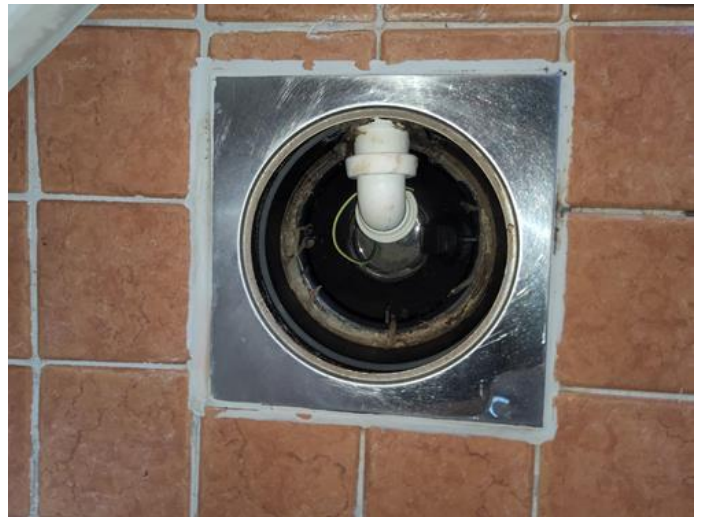
Membran, tettesjikt og overgang til sluk. - [Sluk bad loftsetasje ]
