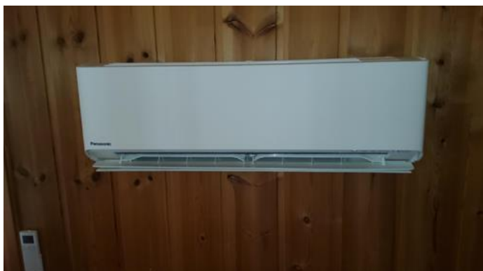
Tekniske anlegg, VVS anlegg (Sjekkpunkter utover det som er inkludert i andre rom) - [Luft til luft varmepumpe]
