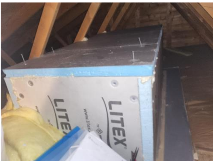
Tekniske anlegg, VVS anlegg (Sjekkpunkter utover det som er inkludert i andre rom) - [Varmtvannsbereder er montert i
