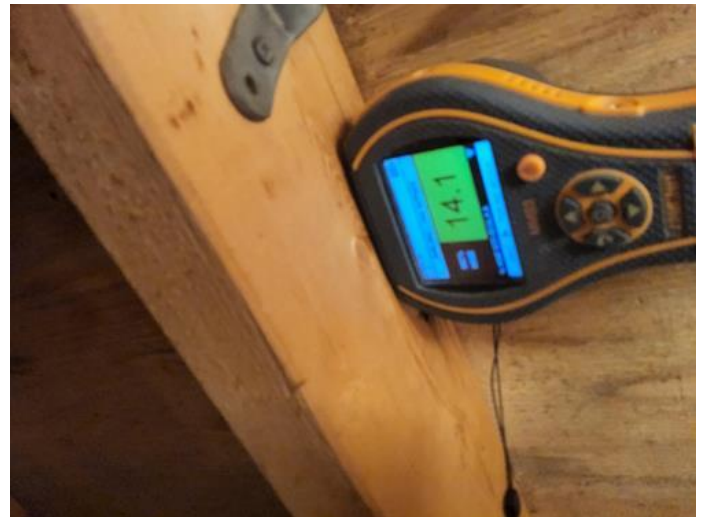
Loft - uinnredet / råloft - [Fuktmåling loft.]
