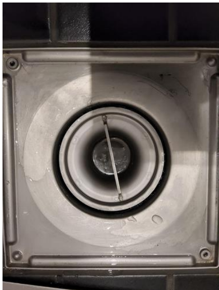
Membran, tettesjikt og overgang til sluk. - [Sluk]
