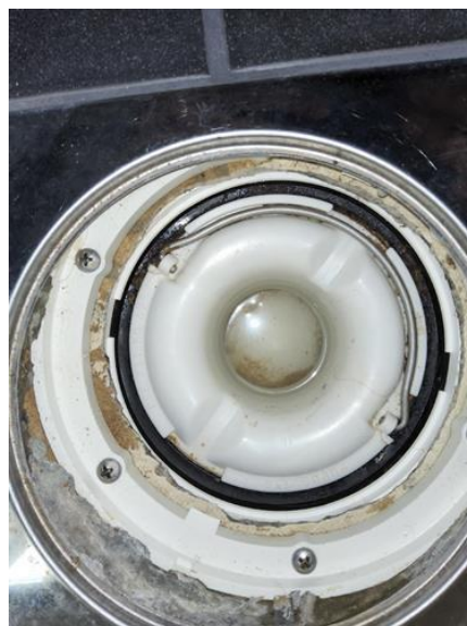
Membran, tettesjikt og overgang til sluk. - [Sluk 2.etg]
