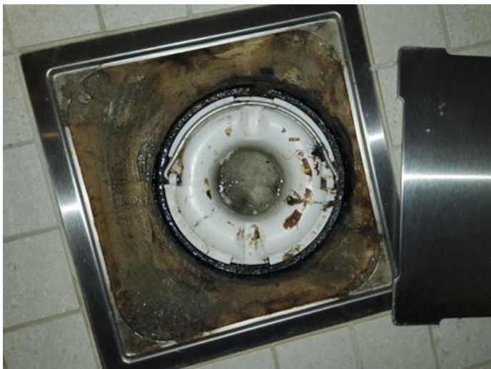
Membran, tettesjikt og overgang til sluk. - [Sluk baderom 1]
