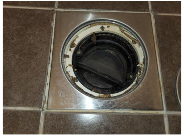
Våtrom - [Sluk på baderommet]
