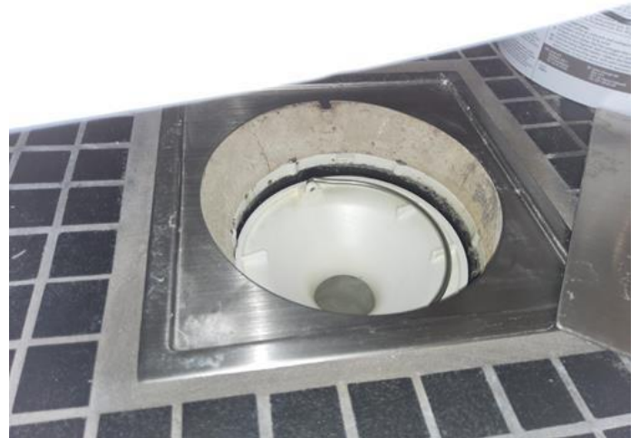
Membran, tettesjikt og overgang til sluk. - [Sluk bad, underetasje.]
