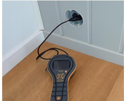
Våtrom - [Hulltaking og fuktmåling i tilstøtende rom til bad i 1. etasje - Gang]
