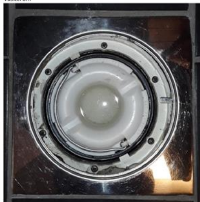
Våtrom - [Sluk - Vaskerom]
