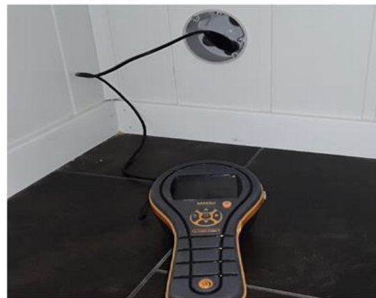
Rom under terreng (kjeller, underetasje, sokkeletasje) - [Hulltaking og fuktmåling i rom under terreng - Bod]
