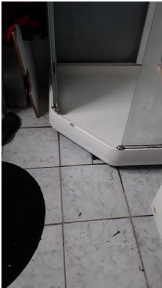
Våtrom - [Sluk bad.]
