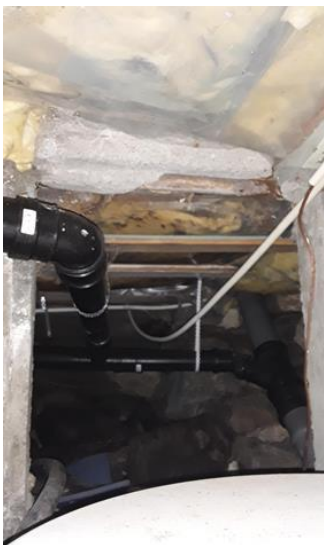
Rom under terreng (kjeller, underetasje, sokkeletasje) - [Uisolerte avløpsrør.]
