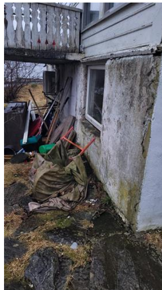
Yttervegger inkl. fasader og konstruksjon - [Pussavskalling.]
