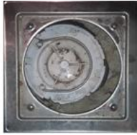
Våtrom - [Sluk under vaskemaskin - Bad underetasje]
