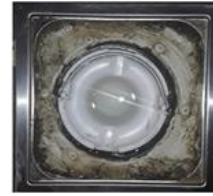
Våtrom - [Sluk i dusjsone - Bad underetasje]
