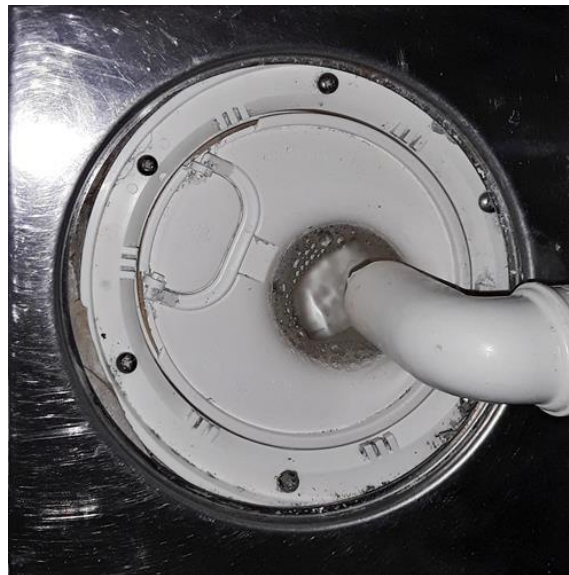
Våtrom - [Sluk vaskerom]
