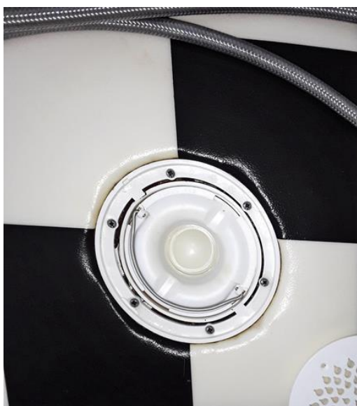
Våtrom - [Sluk bad 2. etasje]
