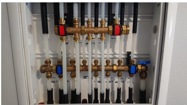
Rør-i-rør skap i vegg i bod. Ingen anmerkninger.
