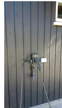
El.bil lader fra byggeår ved inngangsparti i vest.
