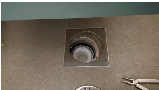
Sluk lå usentret i forhold til flis. Klarte så vidt å løsne kopp fro rengjøring.
