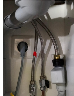
Vannstopp i vaskeskap på vannledning er montert.
