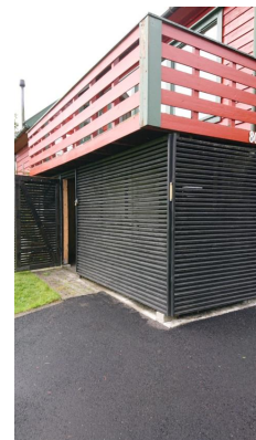
Altan og underliggende klestørke plass.
