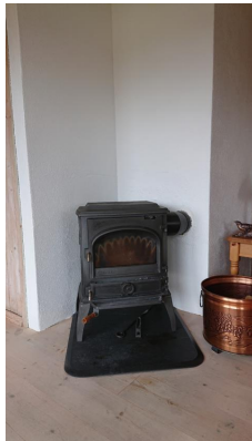
Peisovn i stue. Pusset og malt pipe og brannmur.
