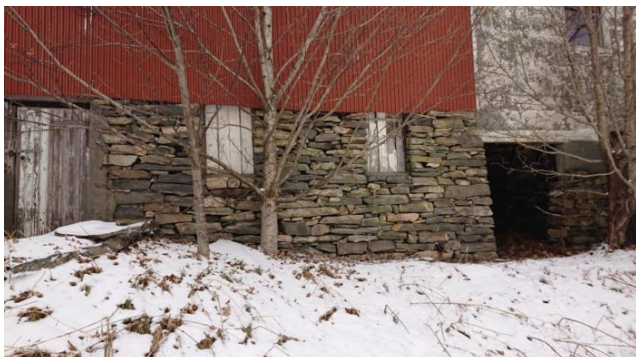
Åpninger i grunnmur i øst er tildekket.
