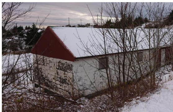
Tilbygget del har betongstein i yttervegger. Slemmet og malt utvendig og innvendig.
