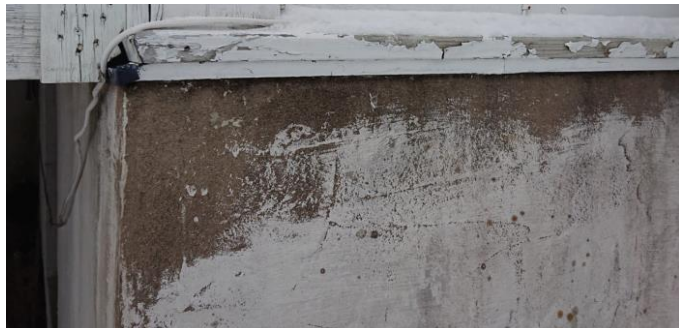
Støpt grunnmur på tilbygget del i øst fra 1930 årene.
