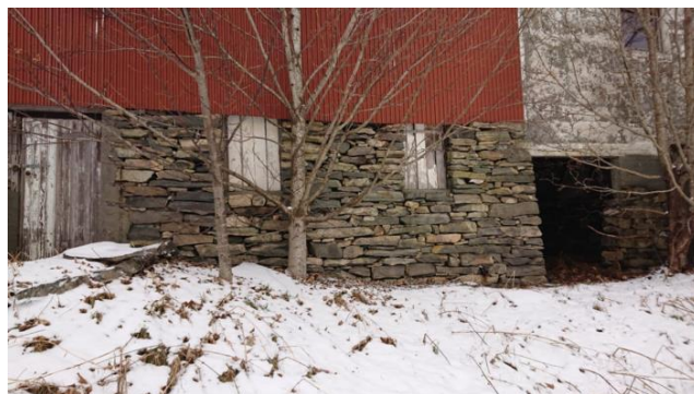
Tørrmurt grunnmur på hele bygget.
