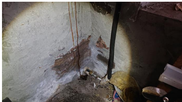
Dagens vanninntak/- antatt.
