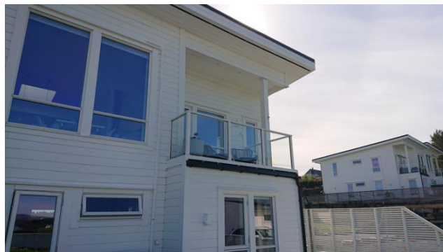
Altan utenfor stue i 2.etasje. Delvis takoverbygget.
