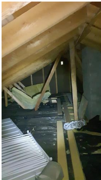
Loft - innredet / råloft - [Isolasjon er ikke på plass]
