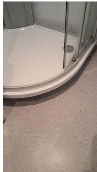
Våtrom - [Bad underetasje]
