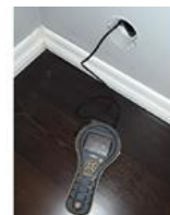
Rom under terreng (kjeller, underetasje, sokkeletasje) - [Hulltaking og fuktmåling i rom under terreng - Bod (soverom)]
