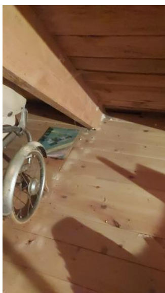
Loft - uinnredet / råloft - [Spor av stripet borebille]
