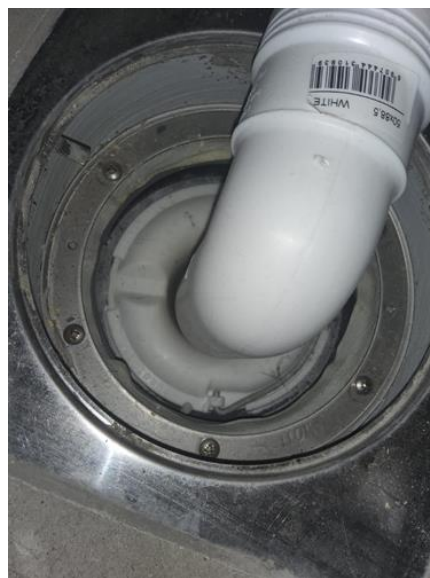
Avløpsrør (ink. sluk) - [Sluk under badekar på bad 1.etasje ]
