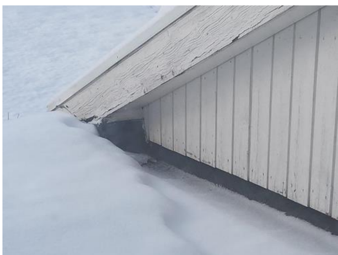
Yttervegger inkl. fasader og konstruksjon - [Råte i vindskie 2.etasje. ]
