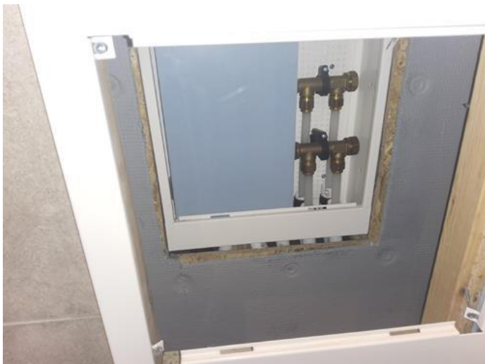
Vannrør (Sjekkpunkter utover det som er inkludert i andre rom) - [Fordelerskap for rør-i-rør på bad 1.etasje ]
