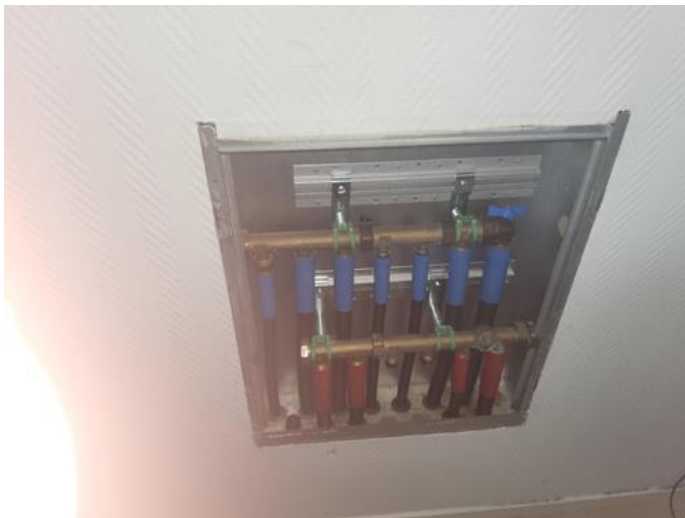
Tekniske anlegg, VVS anlegg (Sjekkpunkter utover det som er inkludert i andre rom) - [Fordelerskap for rør-i-rør i stue i underetasje.]
