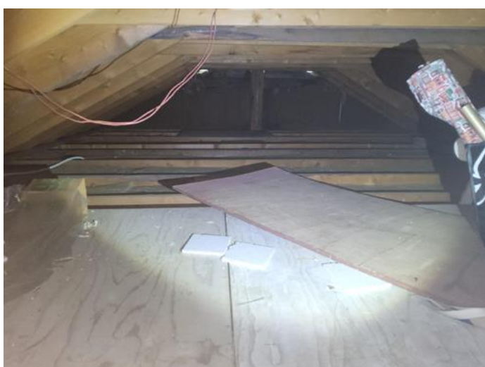
Loft - uinnredet / råloft - [Kaldloft ]
