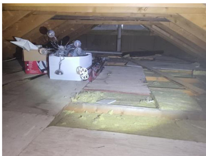
Loft - uinnredet / råloft - [Kaldloft ]
