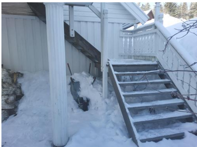
Helhetsvurdering - [Utvendig trapp ved garasje. ]
