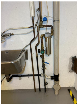
Avløpsrør i vaskerom/fyrrom med stakeluke
