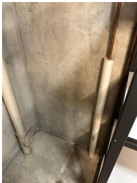
Avløpsrør bak luke i trapperom med stakeluke
