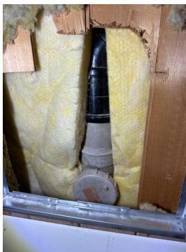
Avløpsrør bak luke i trapperom med stakeluke
