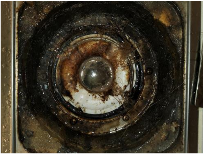
Membran, tettesjikt og overgang til sluk. - [Baderom 1]
