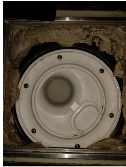
Membran, tettesjikt og overgang til sluk. - [sluk dusj underetasje hoveddel ]
