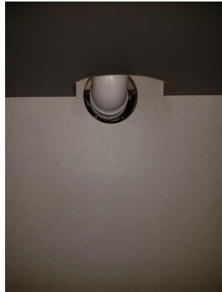
Membran, tettesjikt og overgang til sluk. - [Åpning vegg under servant ]
