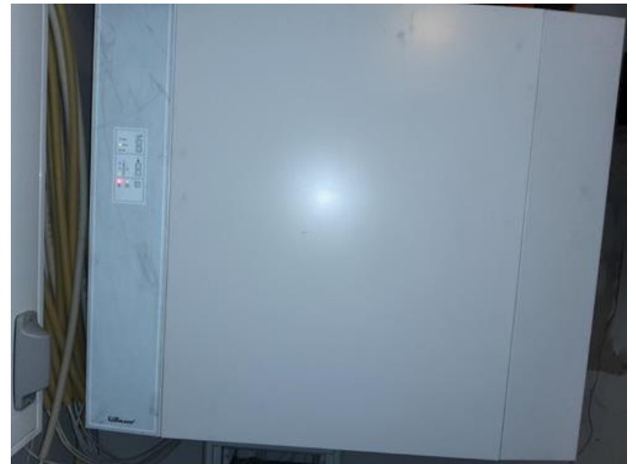
Beskrivelse - [Balansert ventilasjonsanlegg ]
