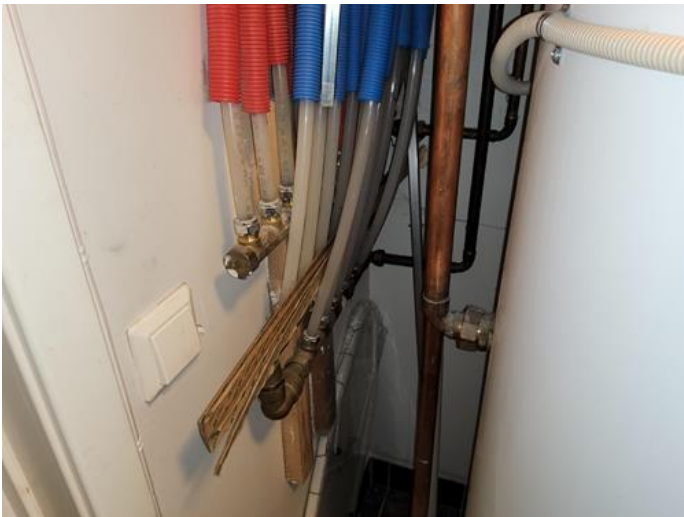
Beskrivelse - [ForFordelerstammer for rør-i-rør-systemet ]
