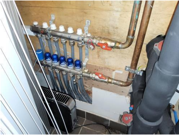
Beskrivelse - [Fordelerstammer gulvvarme ]
