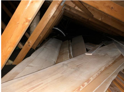
Ventilasjonskanel fra kjøkken mangler isolering
