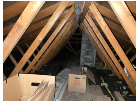
Mye skrot på loftet. Presser isolasjon flat
