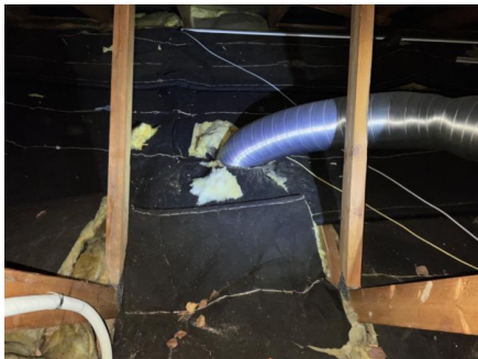
Ventilasjonskanel fra kjøkken mangler isolering
