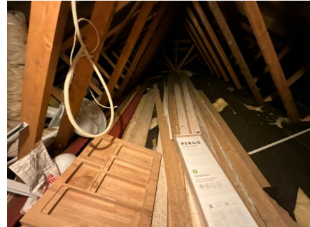
Mye skrot på loftet. Presser isolasjon flat
