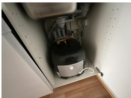
Liten bereder i kjøkkenbenk
