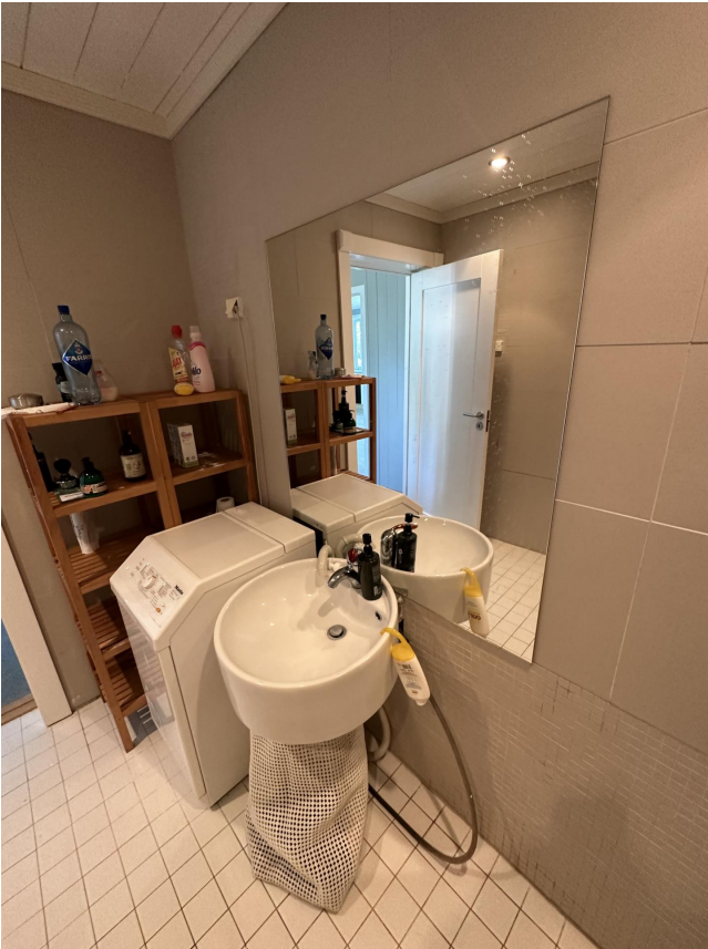
Bad i kjeller tilbygg.
