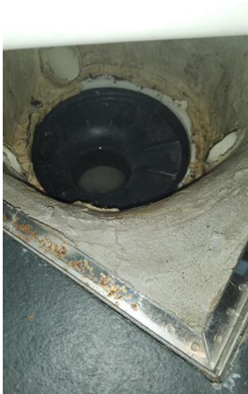
Membran, tettesjikt og overgang til sluk. - [Hovedsluk bad 2.etasje ]
