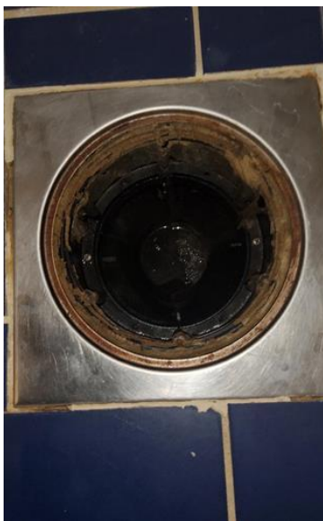
Membran, tettesjikt og overgang til sluk. - [Sluk bad utleiedel ]
