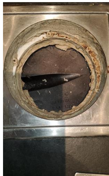
Membran, tettesjikt og overgang til sluk. - [Hjelpesluk bad 2.etasje ]
