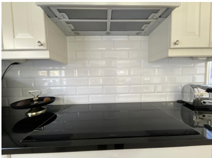
Det er ikke montert komfyrvakt
