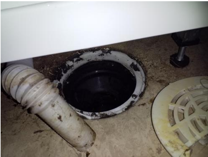
Kommentar - [Sluk under dusjkabinett. Bad i underetasje.]
