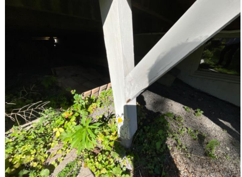
Råte i søyle, Fundament er blitt skjevt
