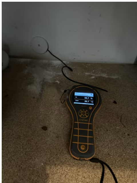
Måler 66.7% relativ fuktighet i utlektet vegg, hvilket er ok.
