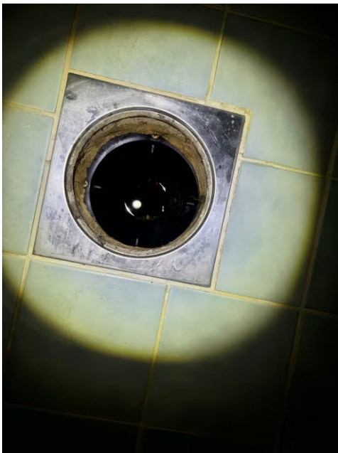
Sluk på bad i 3. etasje.
