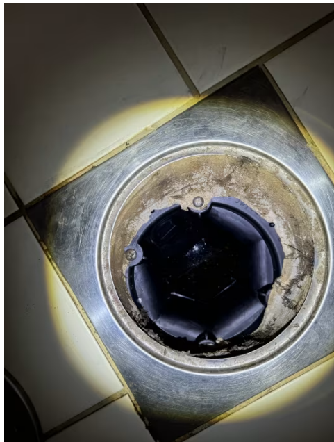
Sluk på bad i 1. etasje.
