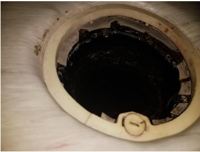
Våtrom - [Sluk bad.]
