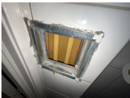
Trolig originale radiatorrør.
