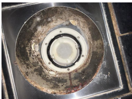
Synlig dukmembran under klemring i sluk.
