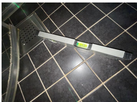
Fallforhold målt i retning sluk.
