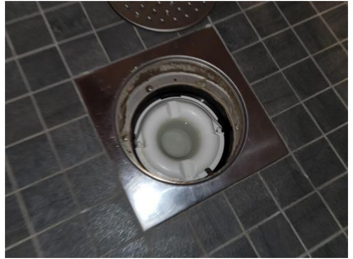
Membran, tettesjikt og overgang til sluk. - [Sluk bad ved entré.]
