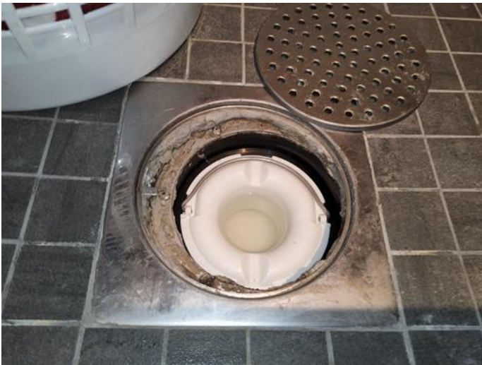
Membran, tettesjikt og overgang til sluk. - [Sluk bad ved soverom.]
