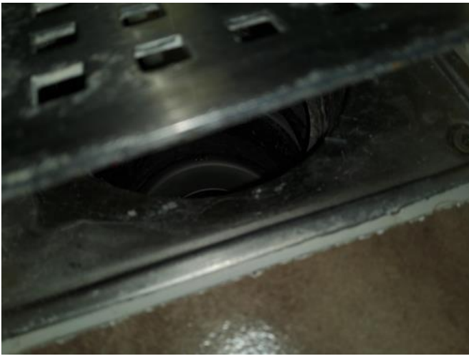
Membran, tettesjikt og overgang til sluk. - [Sluk]
