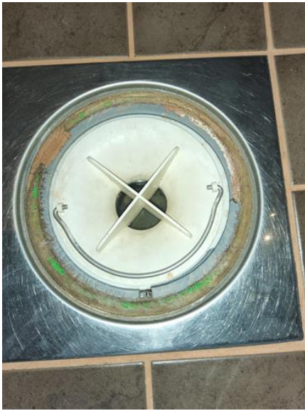
Våtrom - [Sluk bad]
