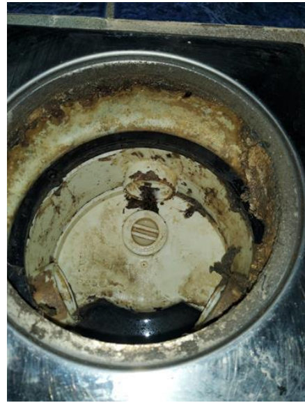
Våtrom - [Sluk bad ]
