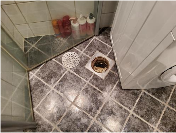
Membran, tettesjikt og overgang til sluk. - [Sluk]
