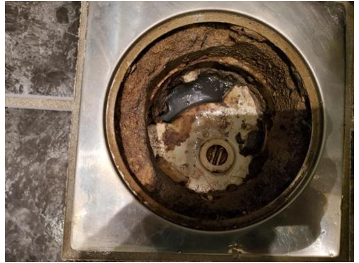
Membran, tettesjikt og overgang til sluk. - [Sluk]
