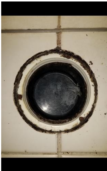
Membran, tettesjikt og overgang til sluk. - [Sluk dusj]
