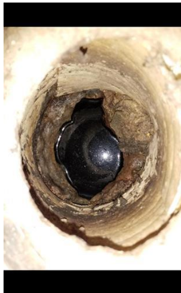
Membran, tettesjikt og overgang til sluk. - [Sluk bad]
