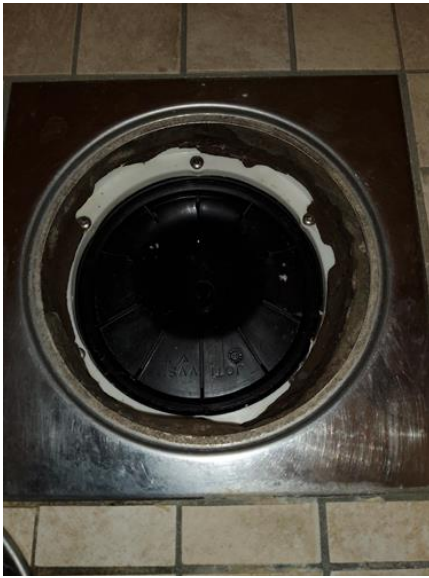
Våtrom - [Sluk bad]
