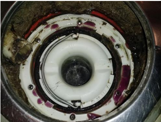
Membran, tettesjikt og overgang til sluk. - [Sluk på bad.]
