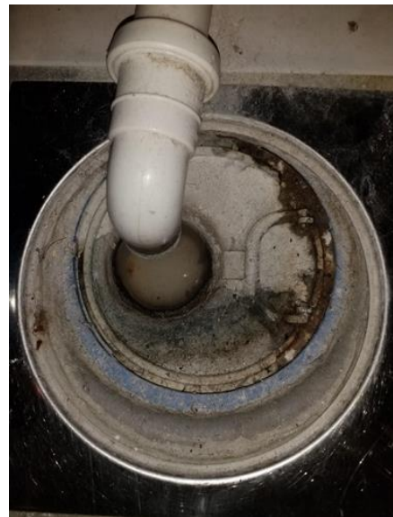
Membran, tettesjikt og overgang til sluk. - [Sluk vaskerom ]
